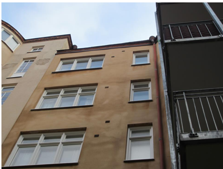
Tilläggsisolerad del av fasad utfört 1984
