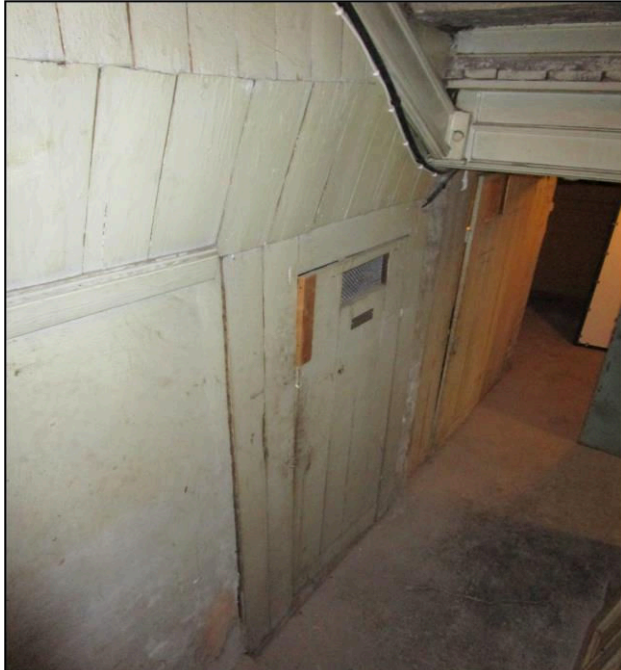
Källare A med träförråd, elcentral och UC
