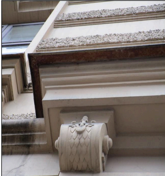
Missfärgningar på fasad och rostutslag på plåtlist
