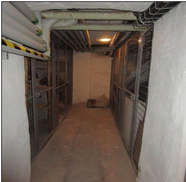
Källare B med Troax-förråd och tvättstuga
