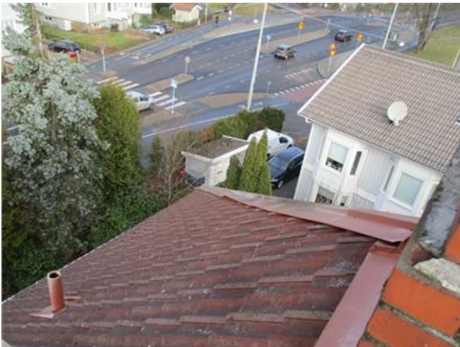
Exempel på plåt som släpper frånnock
