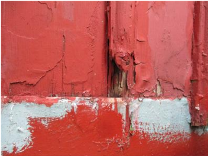
Bild visar plåt på balkong monterad utanpå fasadpanel
