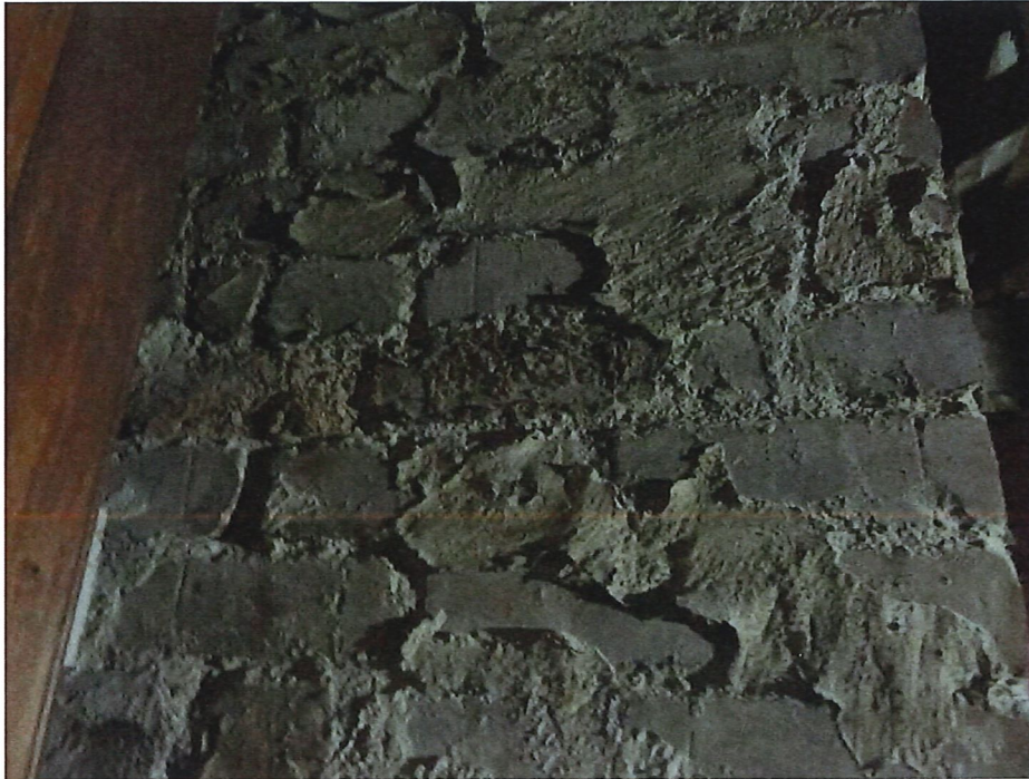
Murstocken på vinden
