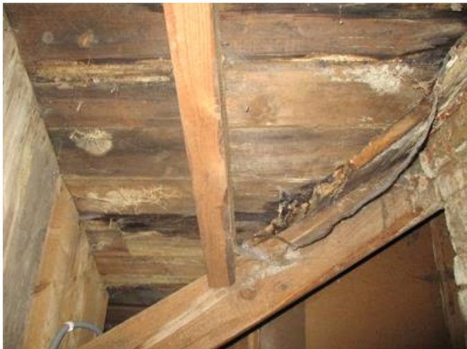
Takläckage i vind och exempel på svampmycel på råspont
