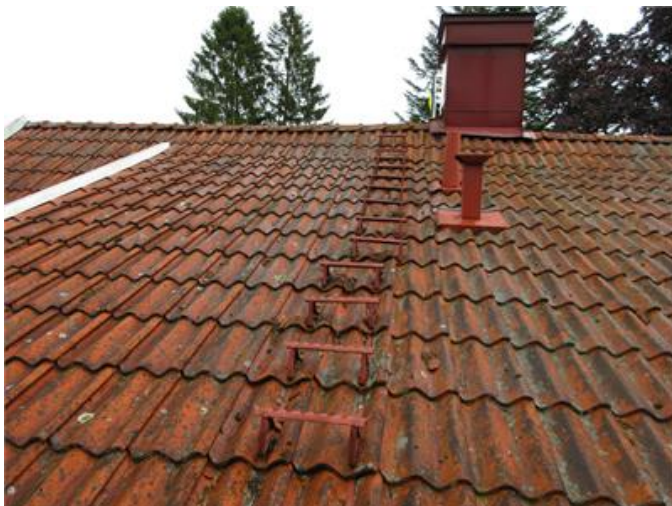
Trasiga/vittrande tegelpannor
