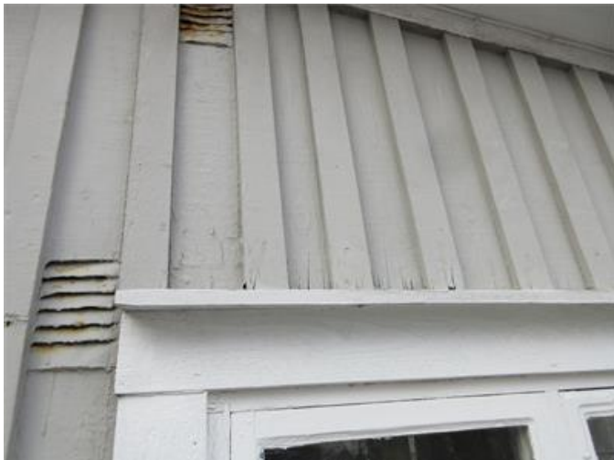
Exempel på torrsprickor/röta i panel
