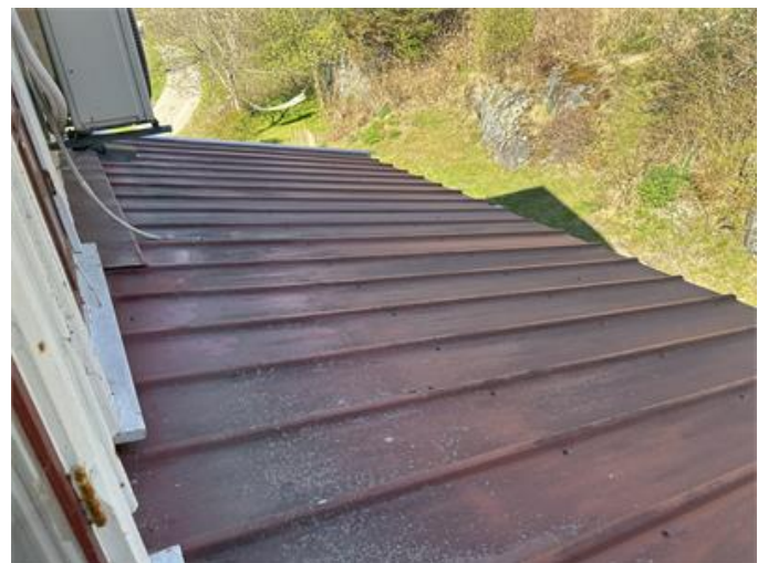
Tak ovan Entre & Dusch/WC/Tvätt: Översiktsbild.
