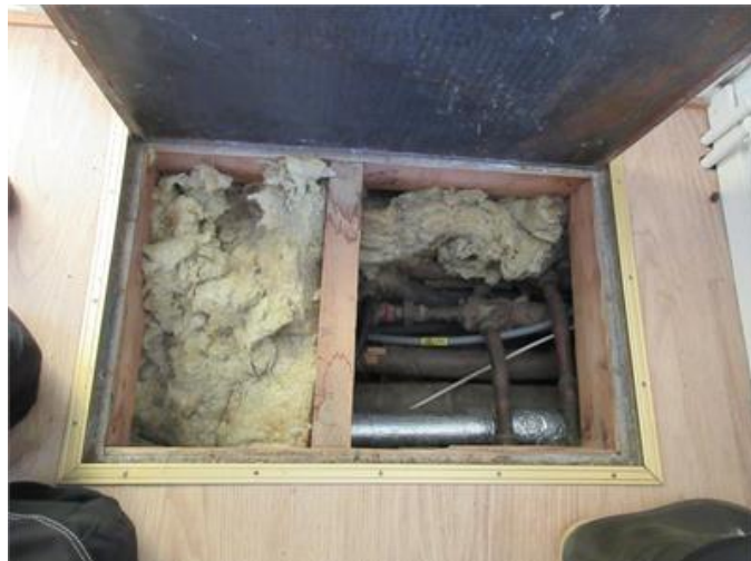
Rörkulvert under entréhall
