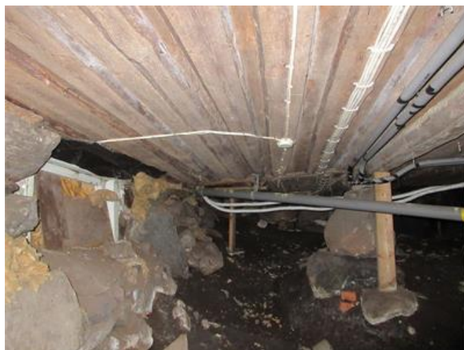
Golvbjälklag uppstöttat med trästöttor
