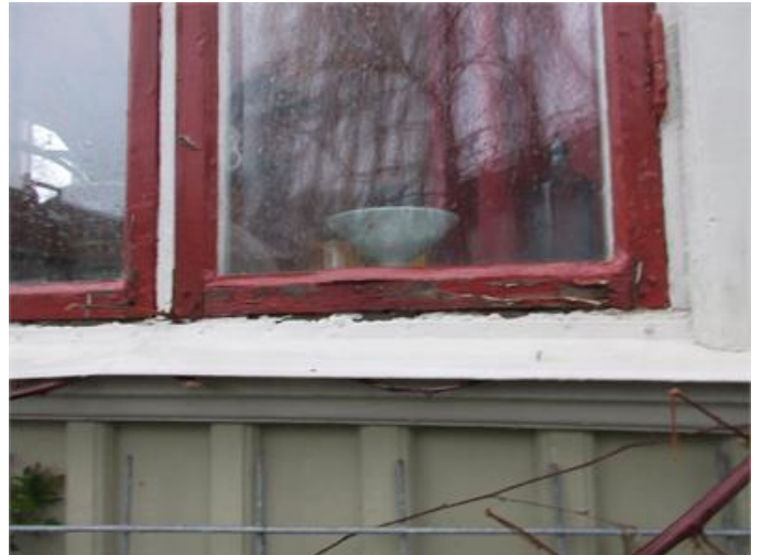
Bild visar torrsprickor/kittsläpp i ett fönster
