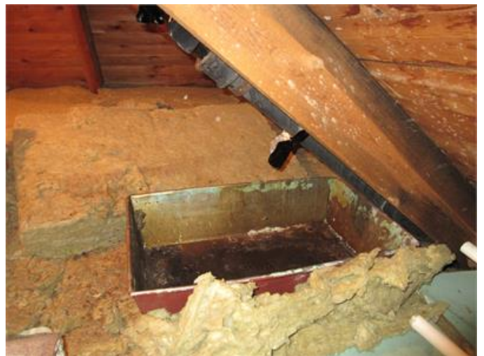
Vatten droppar från taket ner i en balja i vinden
