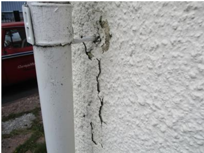
Bild visar exempel på putssläpp
