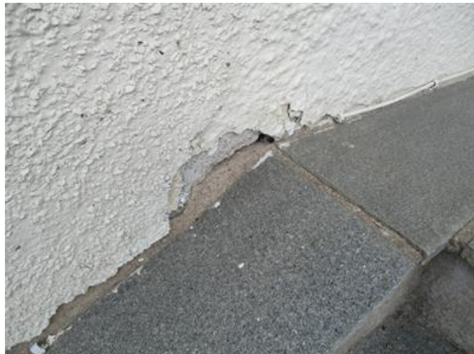
Bild visar exempel på putssläpp
