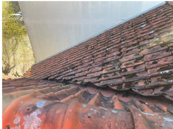
Vy över del av yttertaket.
