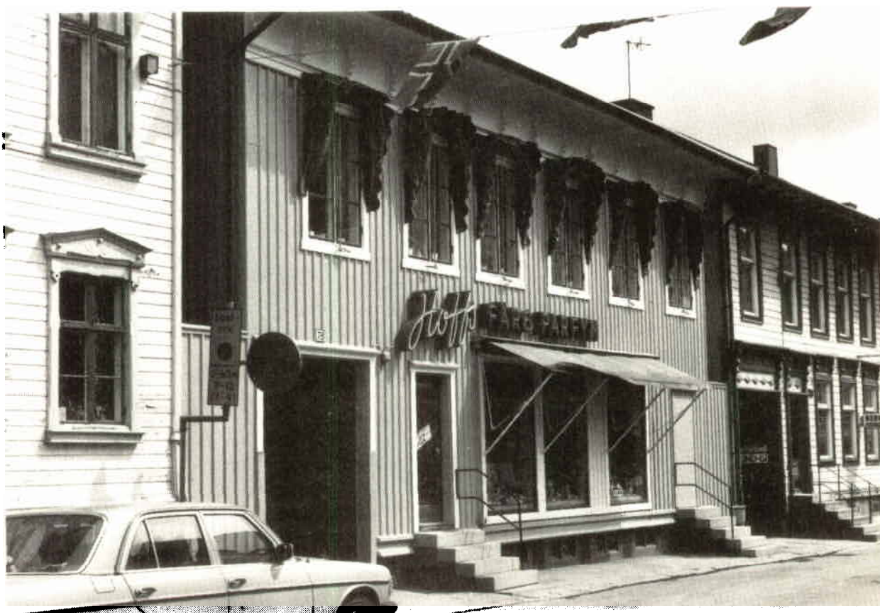
Gatufasaderna kv Krabbetorget 34, 13 och 14
